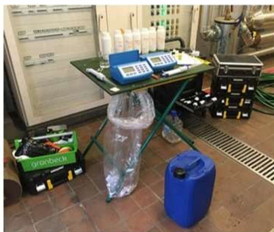
UNA CORRETTA manutenzione e pulizia degli impianti aeraulici riduce la necessità di interventi d'urto di disinfezione e sanificazione
